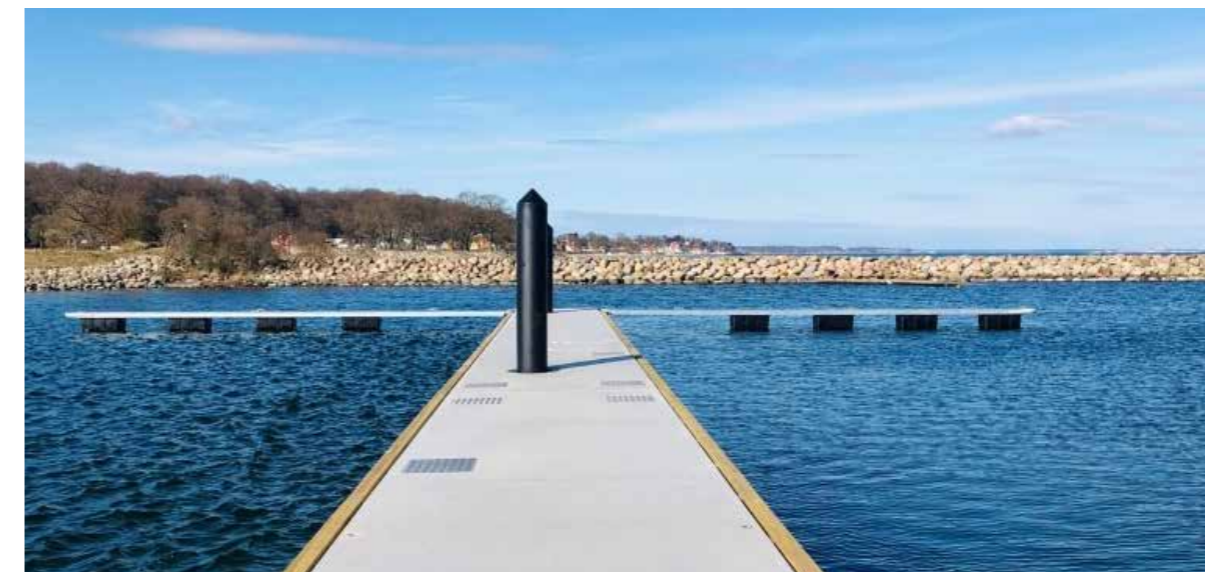
Figur 3.4. Flydebro med pæleforankring integreret i brokonstruktionen
