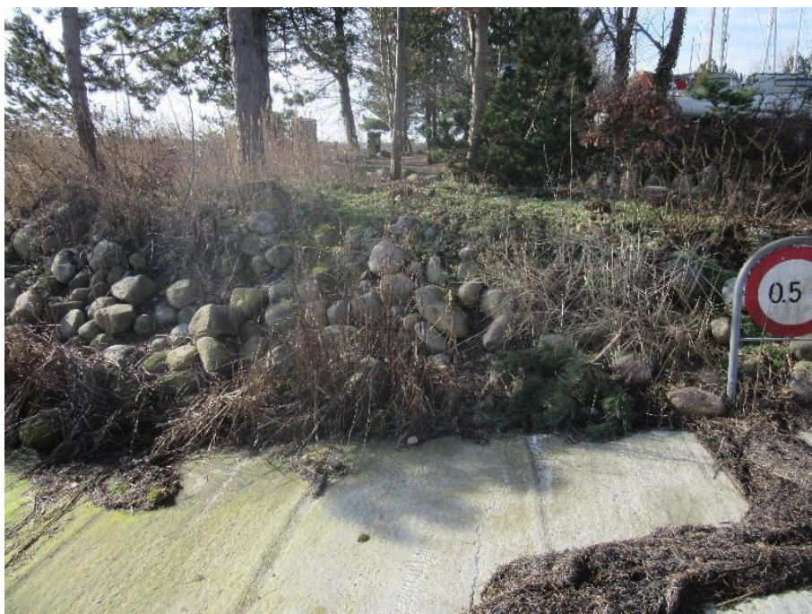
Stejl stensætning ved ophalerplads, med bevoksning mellem stenene.
