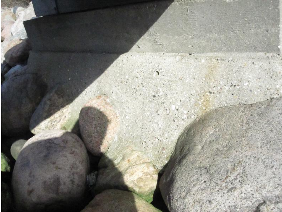
Fundament støbt direkte på stensætning.
