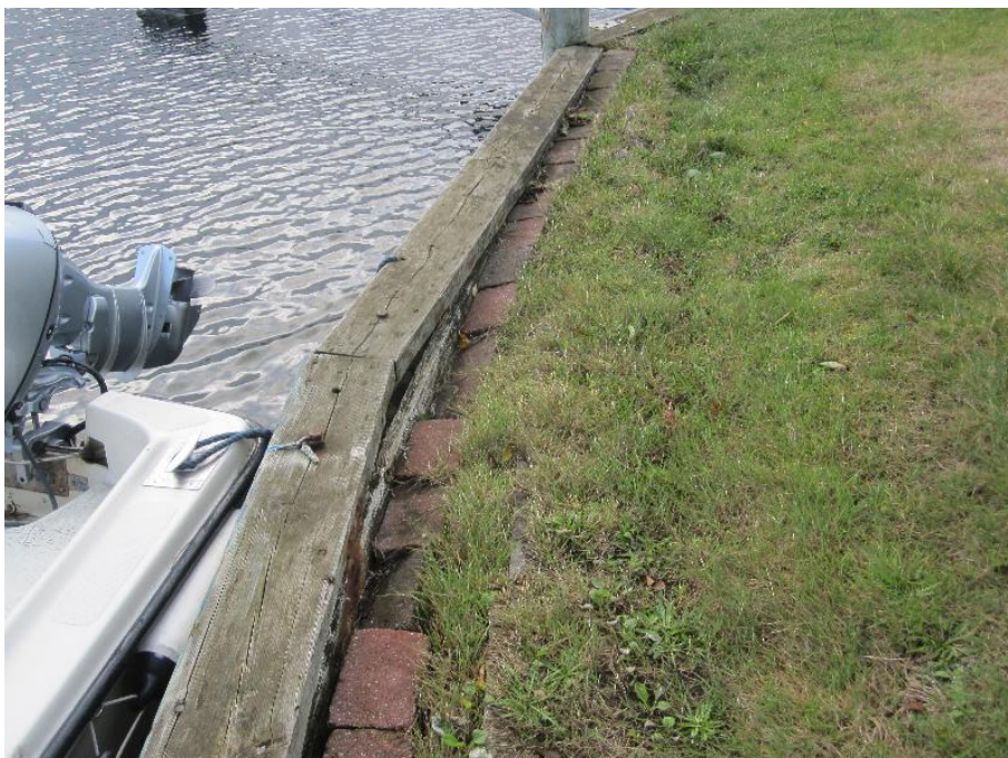
Sat belægningsten og ældet hammer.
