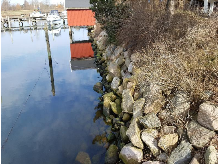
Stejl stensætning mellem bådebro G og H.
