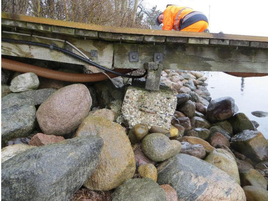
Fundament til bådebro P skredet.
