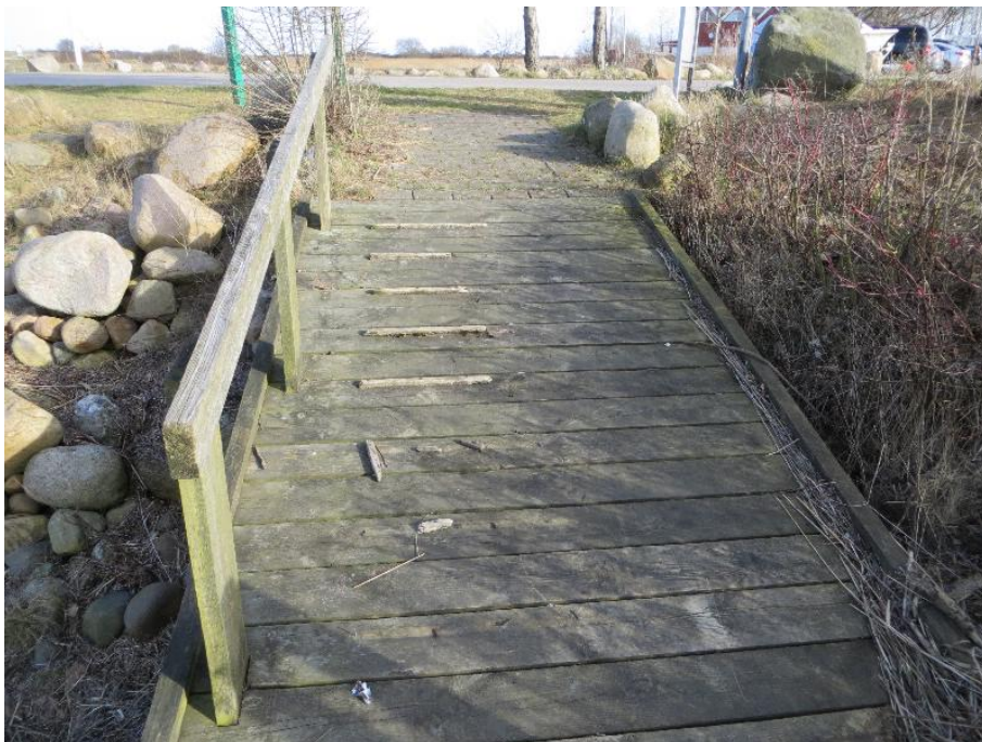
Skridsikring løsrevet ved landgang mod øst.
