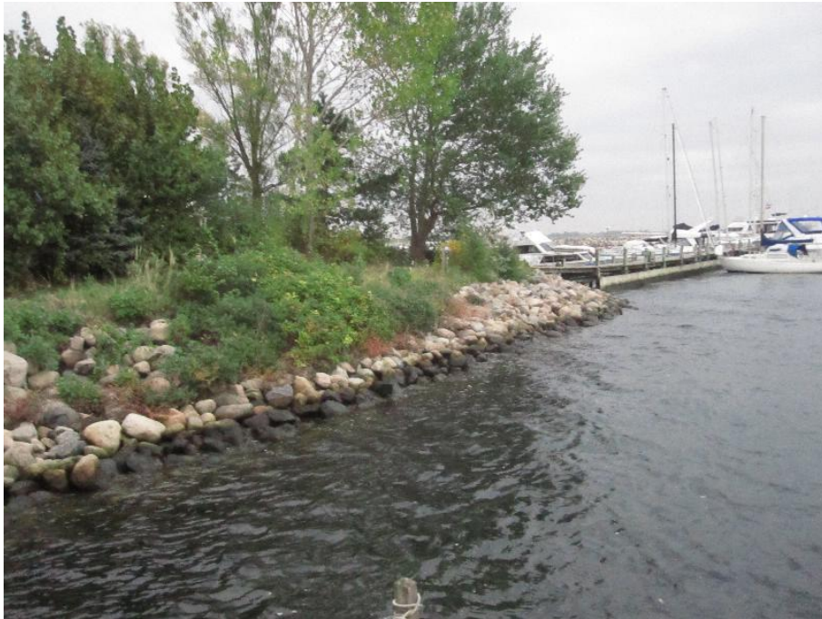
Stensætning, muslingen R, ses med bevoksning.
