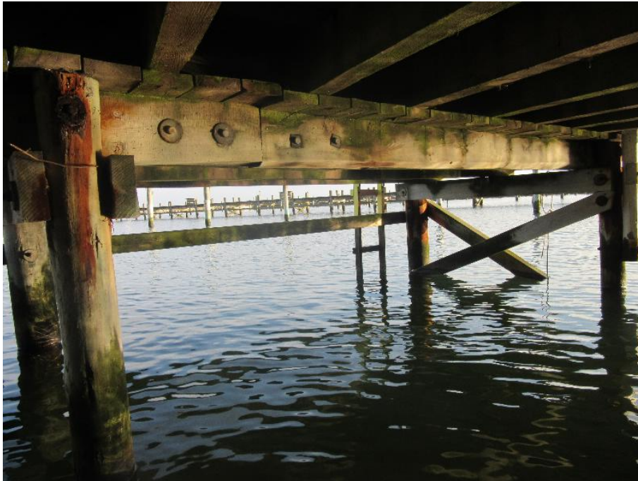
Langsgående bjælke i acceptabel stand, uden skader.
