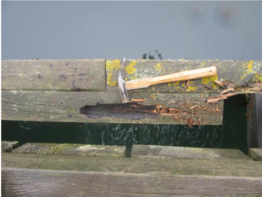
Brandskade på fender ved plads P36.
