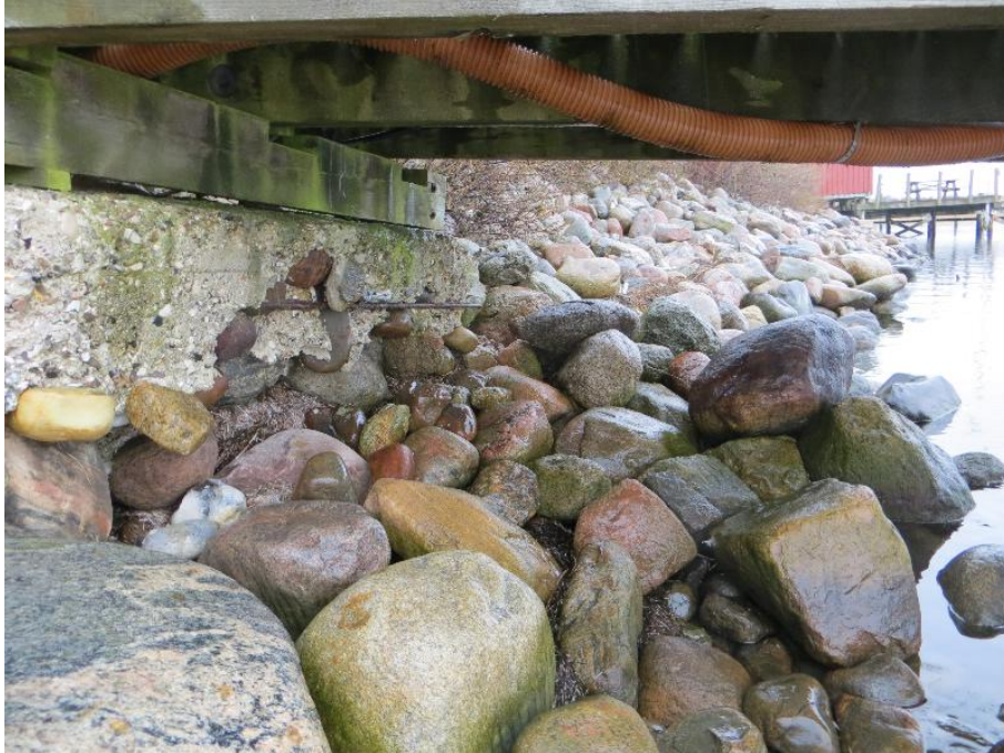
Fundament støbt på skredet stensætning
