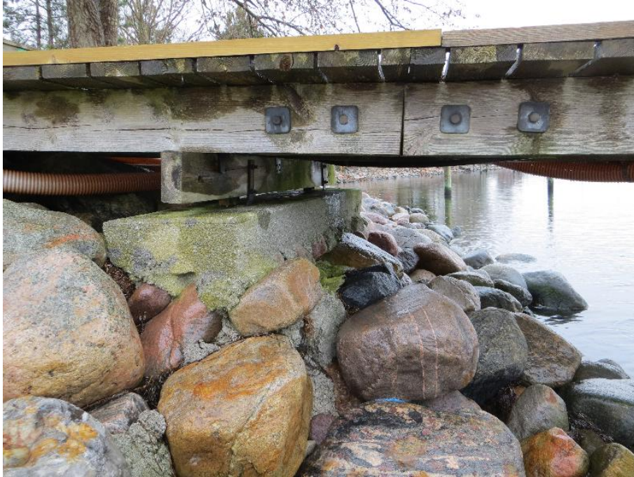
Fundament støbt direkte på stensætning.
