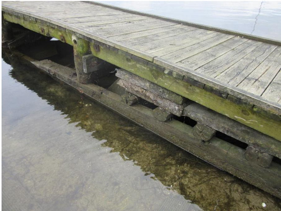
Ballastfliser kilet ind under rampen.
