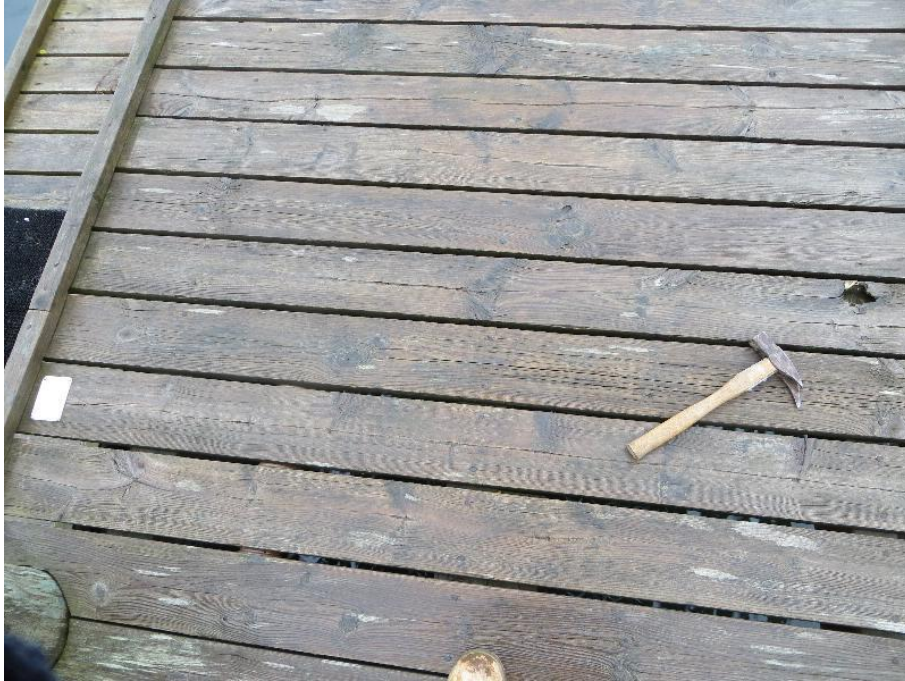
Nedbrudte brædder.
