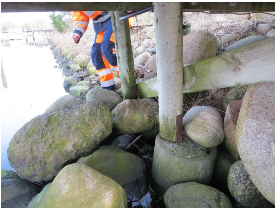
Sydlig ringfundament - yderligt placeret pæl
