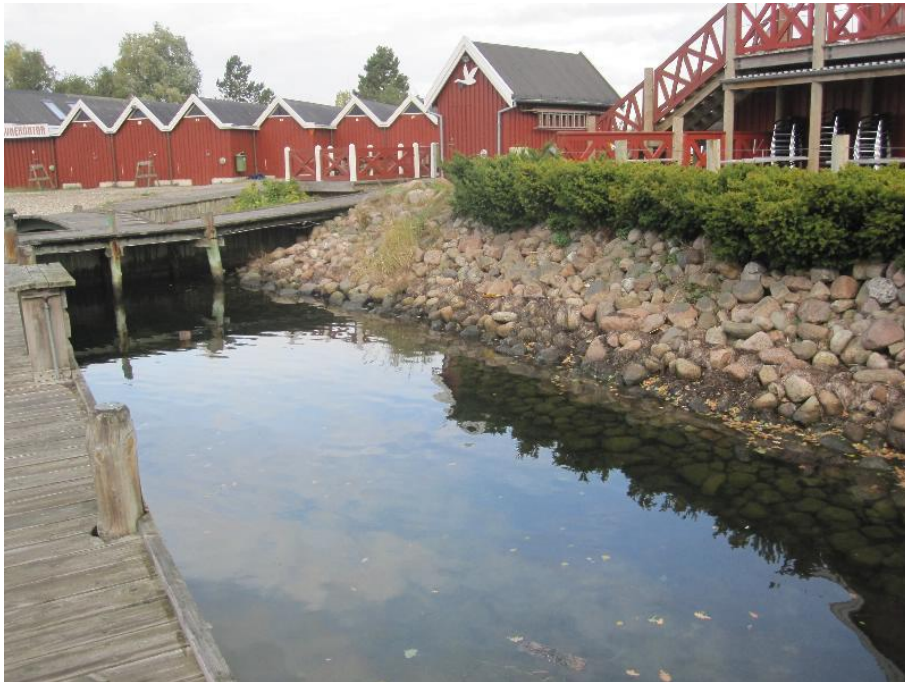
Acceptabel flad stensætning, krabben strækning A.
